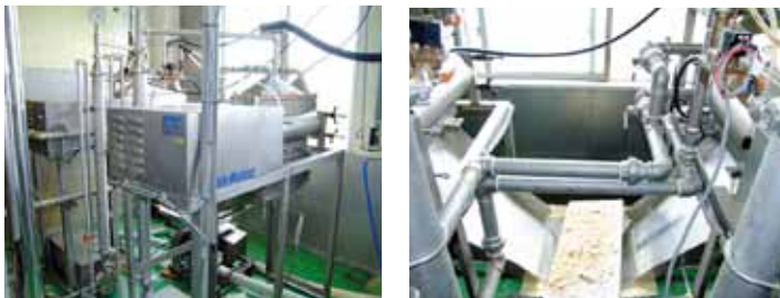
<2Fに設置されている2号機、3号機>
