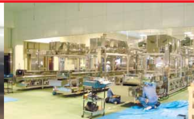
8/6 IHフライヤー3ライン、ボールカッターBCA250を据付
